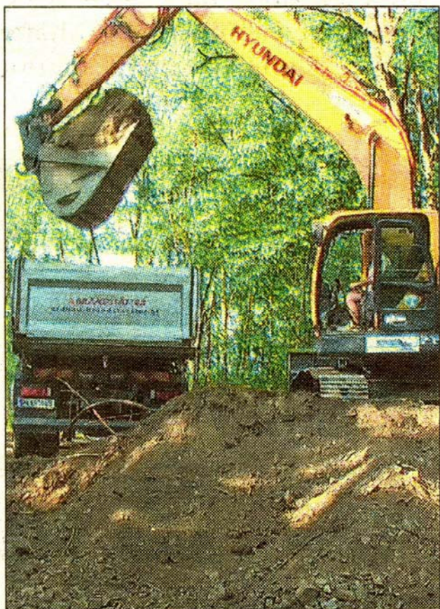
Die Arbeiten am Laabenbach gehen zügig voran. Foto: privat
