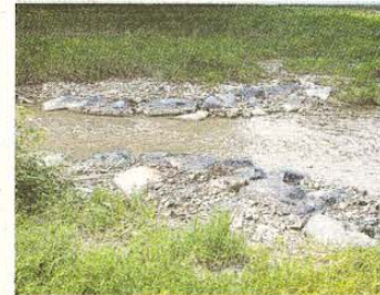
Der „Trichter“ bei der Sturmbrücke erzeugt eine Niederwasserrinne.
