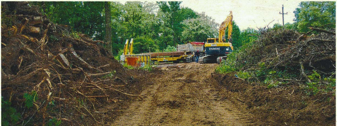
Durch das Projekt steht die gesamte Au als Retentionsfläche zur Verfügung.
