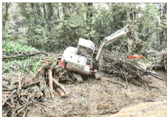
Im neuen Nordgerinne wurden Totholzstrukturen zur Ufersicherung eingearbeitet. Foto: privat
