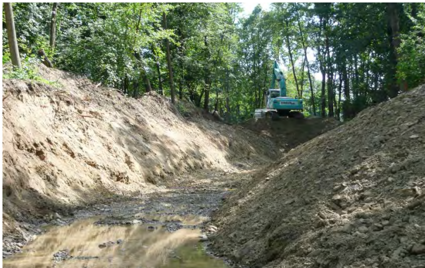
Abb. 6-17: Bau des neuen Verlaufes des Laabenbaches durch den Auwald (Juli 2013)
