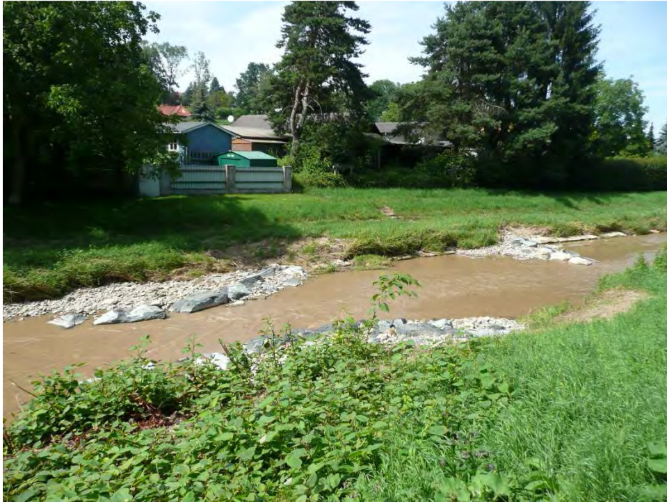
Abb. 2-13: Strömungstrichter und Sichelbuhne im Bereich der angrenzenden Siedlung ca. bei Fkm. 26,6 (Juli 2013)
