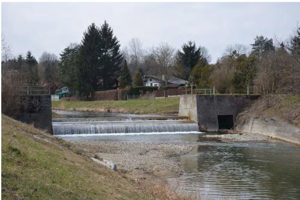
Abb. 2-14: Bestehendes Wehr – Fkm. 23,52 (März 2013)
