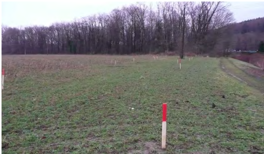
Abb. 6-2: Aussteckung des neuen Verlaufes des Dammbaches (Jänner 2013)
