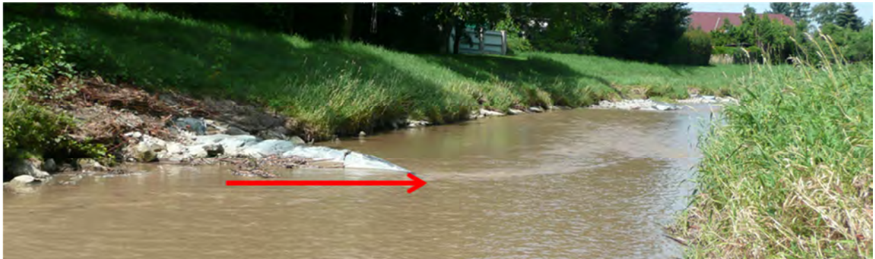
Abb. 3-5: Lenkung der Strömung in Flussmitte durch die deklinant eingebaute Sichelbuhne bei Fkm. 26,67 (Juli 2013)
