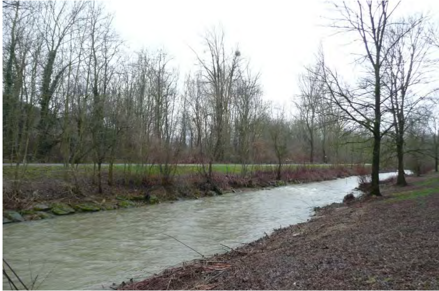
Abb. 6-4: Begradigtes Trapezprofil des Laabenbaches im oberen Projektgebiet, zukünftige Flutmulde (Jänner 2013)
