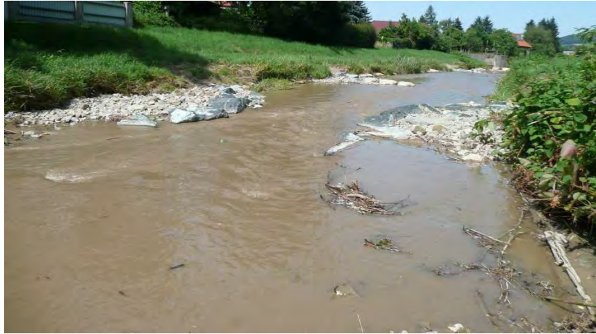
Abb. 6-13: Strömungstrichter 2 und Sichelbühne 2 im Untersuchungsgebiet bei Fkm. 23,63 bzw. Fkm. 23,61 (Juli 2013)
