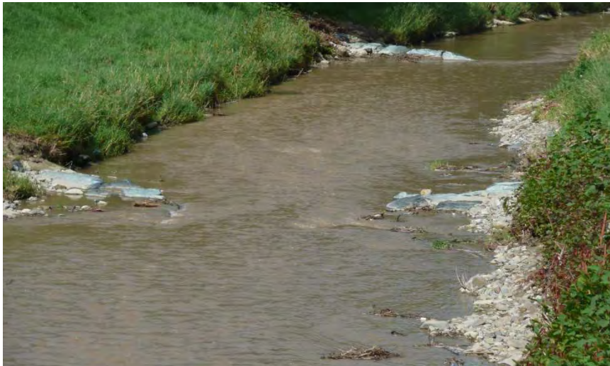
Abb. 6-14: Strömungstrichter 1 und Sichelbühne 1 im Untersuchungsgebiet bei Fkm. 23,72 bzw. Fkm. 23,67 (Juli 2013)
