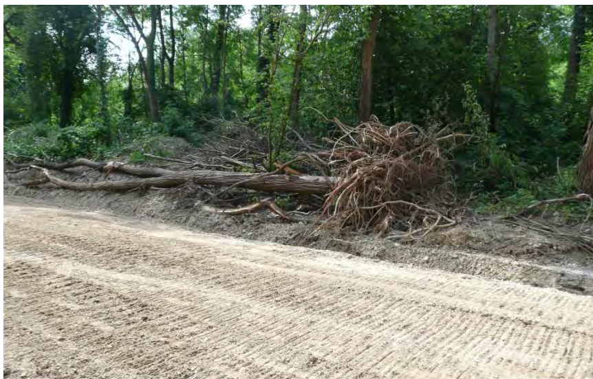
Abb. 6-18: Rauhbaum bereit für den Einbau (Juli 2013)
