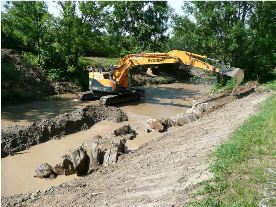
Abb. 2-12: Abschnittsweise Aufweitung eines bestehenden Profils ca. bei Fkm. 24,3 (Juli 2013)
