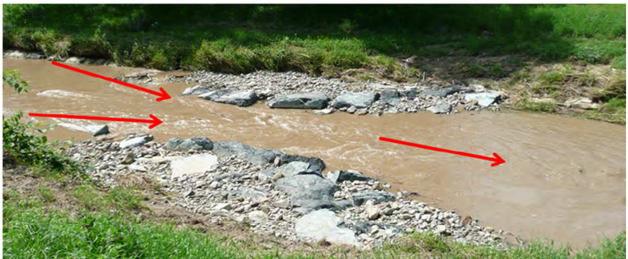
Abb. 3-9: Beschleunigung der Strömung in Flussmitte durch den eingebauten verkehrten Strömungstrichter bei Fkm. 23,63 (Juli 2013)
