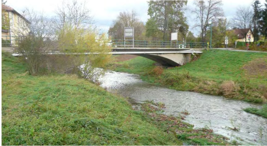
Abb. 6-1: Blick auf die Sturmbrücke, Blickrichtung: flussabwärts (November 2012)
