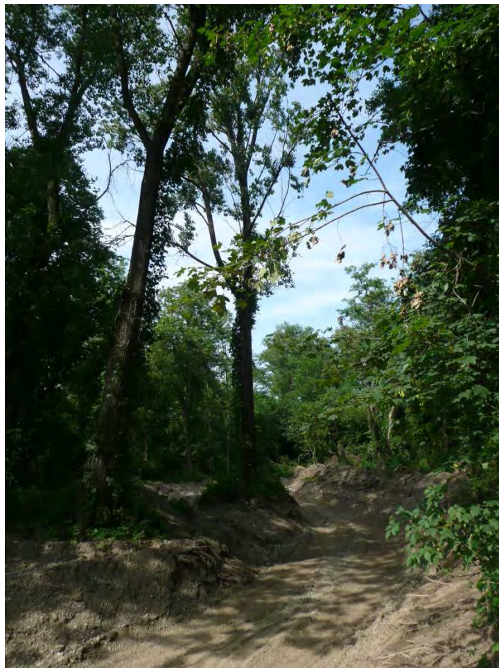
Abb. 2-11: Angepasste Linienführung bei der Ausleitung zur Erhaltung des Baumbestandes (Juli 2013)
