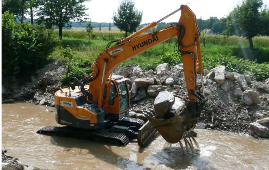
Abb. 6-16: Transport der Wasserbausteine innerhalb des Laabenbaches (Juli 2013)
